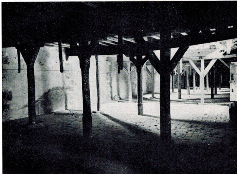
L'intérieur du grenier d'abondance est dans un état de conservation exceptionnel.
