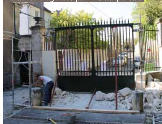
Le démontage des pierres du portail
