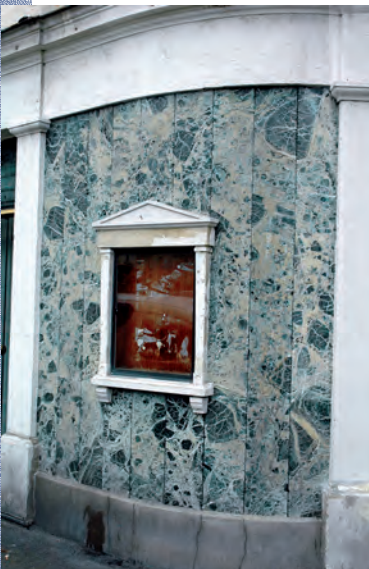
Figure 20. Pan de mur en serpentinite. Cette roche s'est formée au milieu d'un océan. Le magma émis au niveau d'une dorsale océanique a été altéré par des fluides hydrothermaux (les veinules correspondent aux zones de circulation) et mis à l'affleurement par des mouvements tectoniques (on en trouve dans les Alpes, les Pyrénées, etc.). Sa couleur, oscillant entre le vert clair et le vert très foncé, évoque la peau d'un serpent, d'où son nom de serpentinite. © P. De Wever
