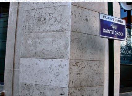
Figure 19. Angle de la rue de la Juiverie et de la rue Sainte-Croix. Pierres de parement en Comblanchien. © P. De Wever
