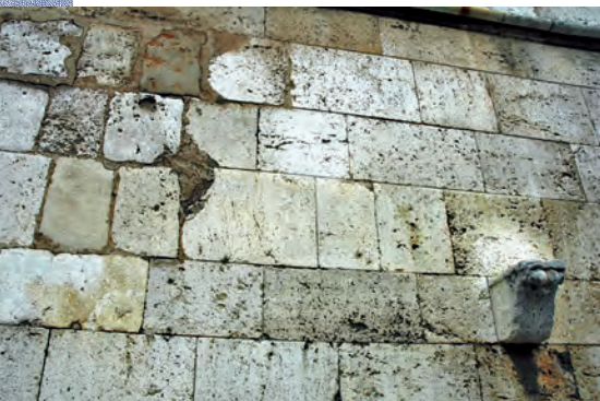
Figure 6. Mur de l'église Saint-Basile, face à la bibliothèque, rue Sainte-Croix. Le mur est constitué d'un calcaire lacustre dans lequel on reconnaît des restes d'organismes qui vivent dans des lacs : planorbes (petits escargots aplatis) et limnées (escargots allongés) © P. De Wever
