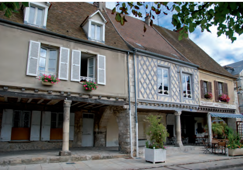
Figure 32. La maison des piliers, XI^e siècle. La partie centrale, refaite récemment, montre très clairement l'architecture originelle. © P. De Wever
