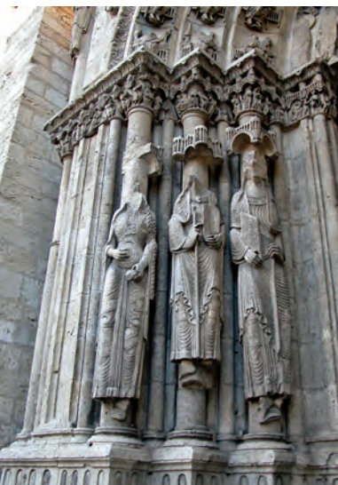
Figure 16. Les sculptures du portail sont constituées par un calcaire appelé Liais, très riche en milioles (d'où son autre appellation de calcaire à milioles). Les milioles sont des organismes marins unicellulaires à coquille (foraminifères). Elles s'observent à la loupe : tous les petits points blancs que vous pouvez observer sur le calcaire sont des milioles. Les géologues les identifient en prélevant un échantillon de roche et en réalisant des lames minces qu'ils étudient au microscope (voir figure suivante). Cette roche est choisie de préférence aux autres pour les fines sculptures parce que son grain est fin et sa texture homogène.
