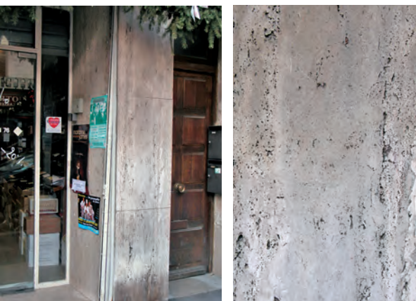
Figure 18 a. Place Notre-Dame. Parement de devanture en travertin. La pierre, utilisée en placage de décoration ne doit rien soutenir, elle a pu être posée en « délit ».
